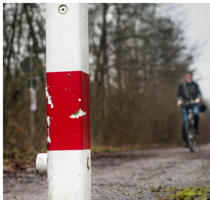
Macken am Fuß von Pollern - untrügliches Zeichen für Kollisionen mit unter Umständen schlimmen Folgen.
